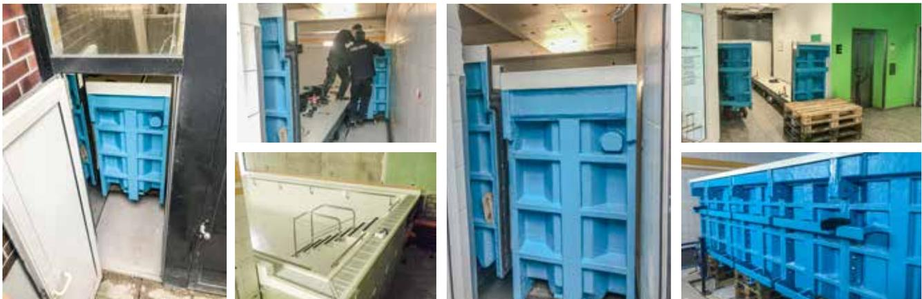
Die acht Segmente wurden im VPS-Werk vorproduziert. Da die Teile zwischen 70 und 90 cm breit waren, passten sie durch normale Türen. Erst in der Schwimmhalle wurden sie dann fugenlos miteinander verbunden. Die Ausrichtung war Millimeterarbeit. Das Becken ist jetzt exakt in den zur Verfügung stehenden Raum eingepasst. Die Statik entspricht mindestens der eines Einstückbeckens.
